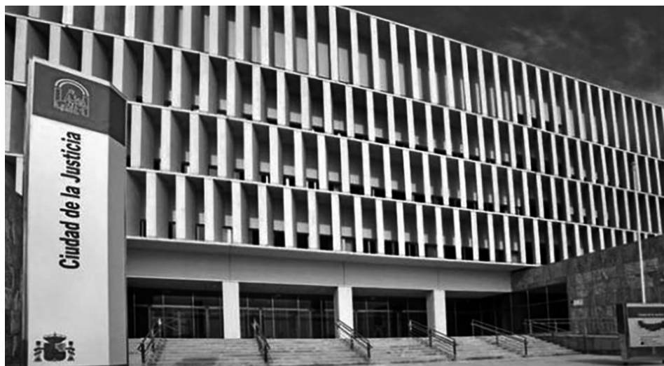
Foto 3. Edificio de la Ciudad de la Justicia de Málaga. Inaugurado en el año 2007.
